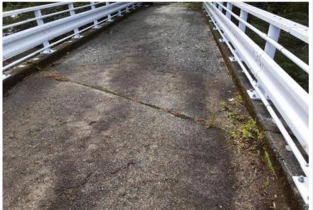
施工前 温度変化によるコンクリート橋伸 縮のための遊間部が劣化し、損傷
